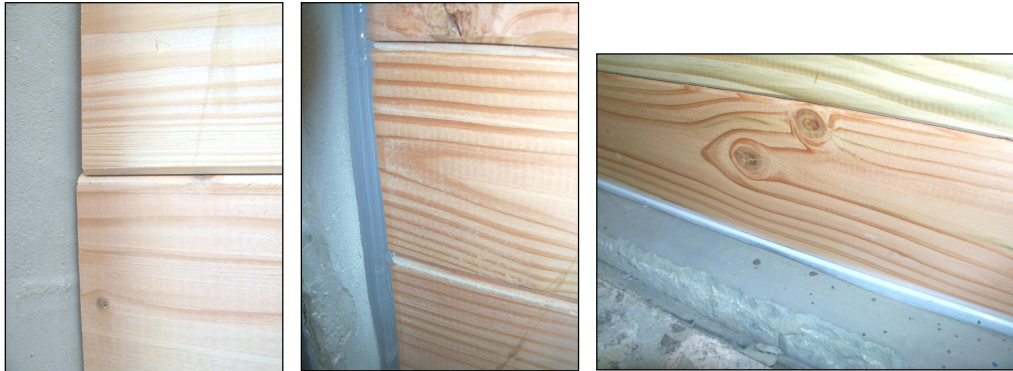
Imágenes 17 a 19 Encuentro lateral y posterior sellado y sellado en arista inferior
